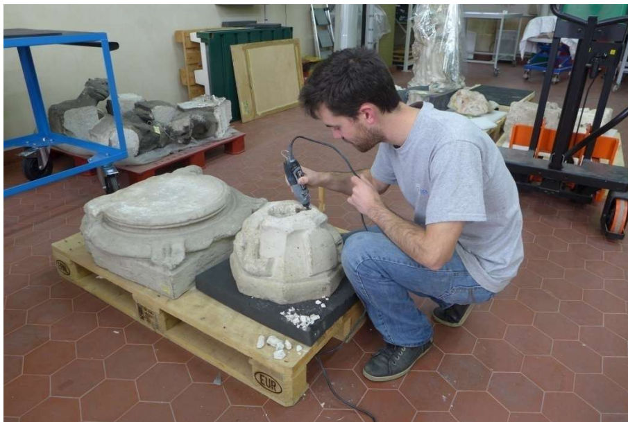
Traitement des éléments métalliques corrodés.
