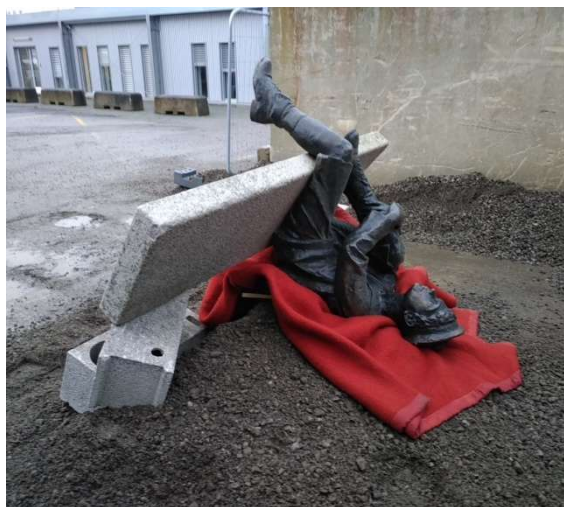
Positionnement pour retrait de l'ancienne assise.
