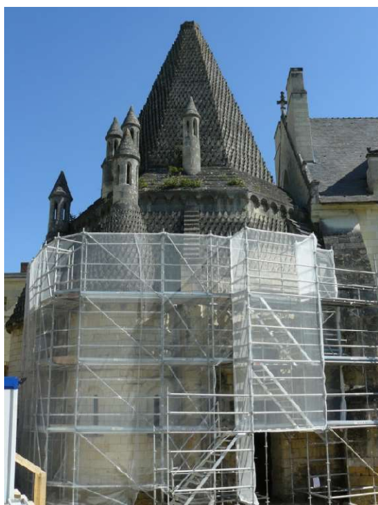
Vue d'ensemble du chantier en cours.
