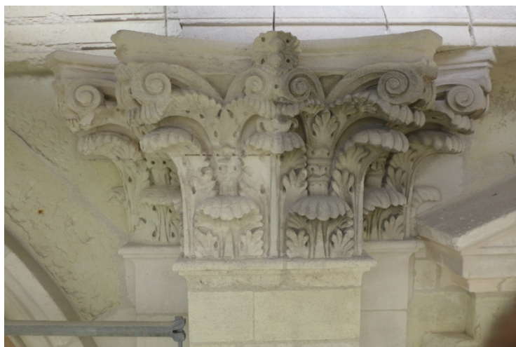
Chapiteaux extérieur à mi-nettoyage
