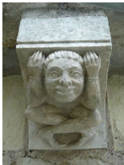
Modillon en cours de nettoyage
