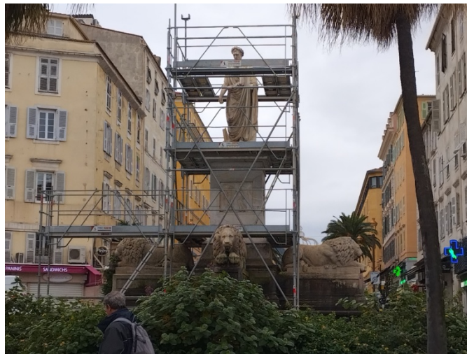
Implantation du chantier.
