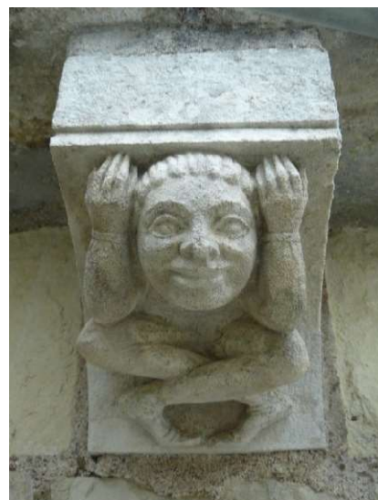
Modillon en cours de nettoyage.
