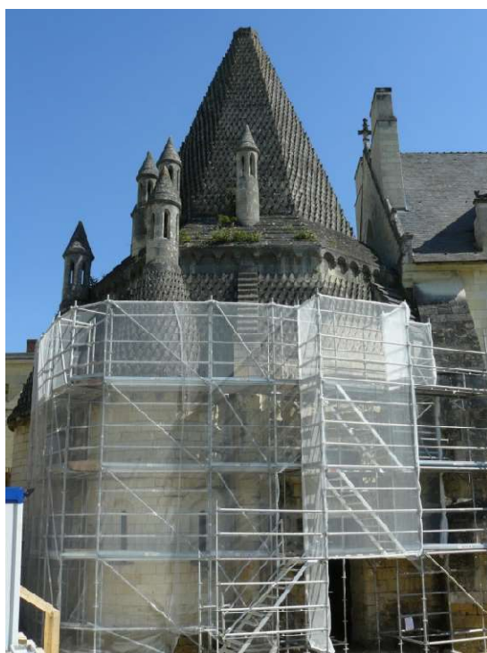
Vue d'ensemble du chantier en cours.
