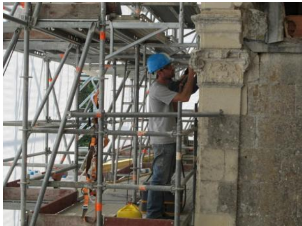
Nettoyage en cours (©photo Julien Coquet 2015).
