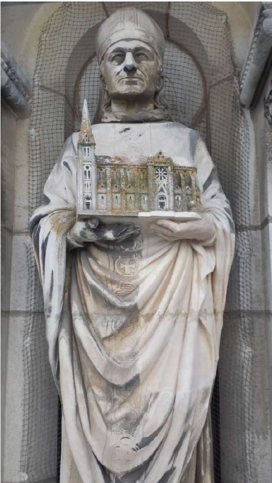
Sculpture en cours de nettoyage.
