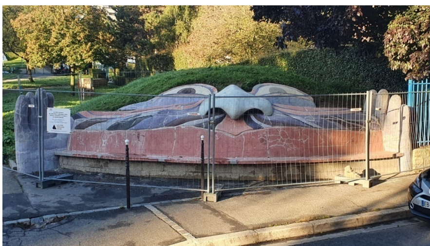
Après nettoyage, consolidations, bouchages et réfections.
