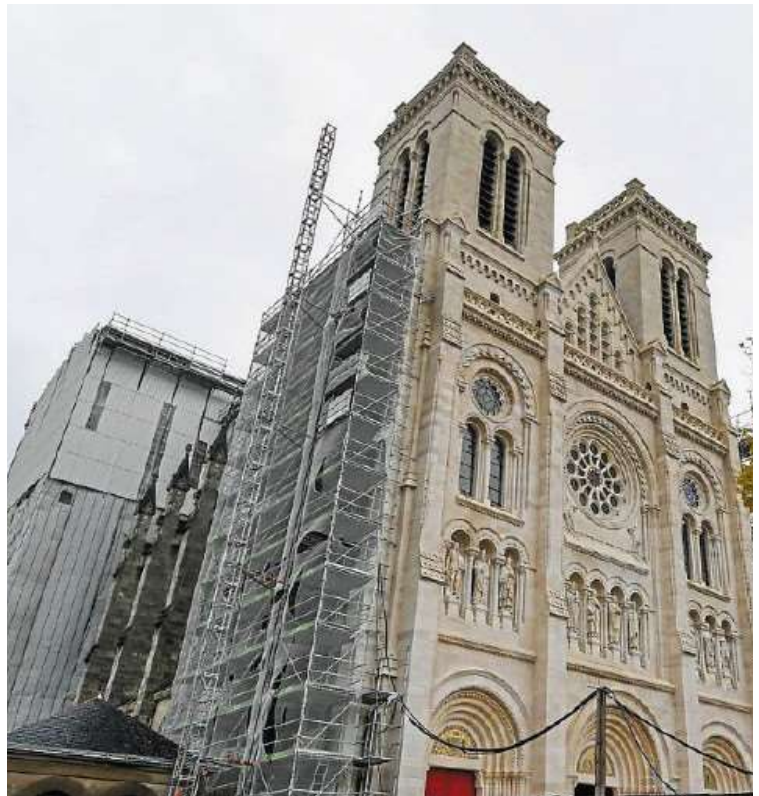
Façade après traitement.
